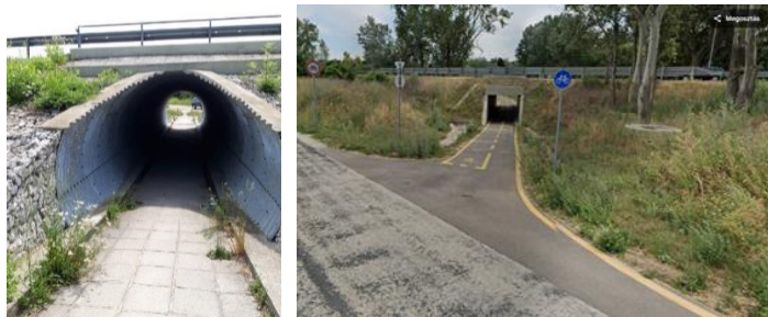
15. ábra: 13.000-15.000 jm/nap feletti forgalomnagyság és 90 km/órás járműsebesség esetén példák külön szintű kerékpáros átvezetésre
