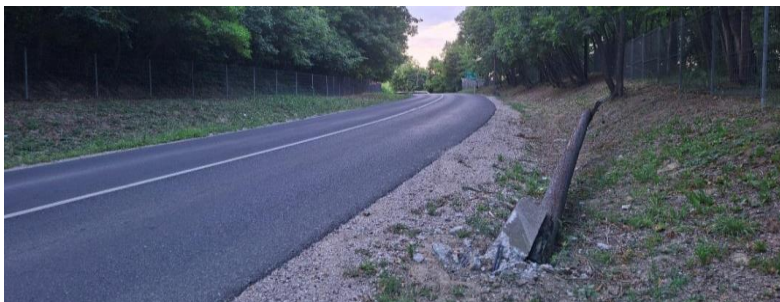
7. ábra: Kidőlt telefonoszlop a 103-as főúton
