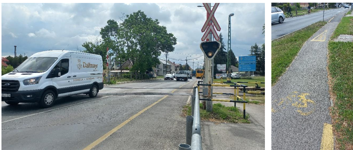
11. ábra: Szokatlan kialakítású „labirintkorlát” a védtelenek áthaladására (Győr, 82. sz. főút, 10. sz. vasútvonallal való keresztezése)
