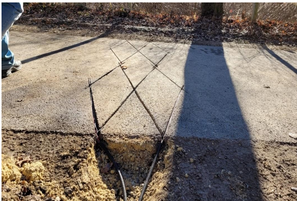
2. ábra: Eco-Counter hurokdetektor elhelyezése (forrás: Értékterv Kft.)
