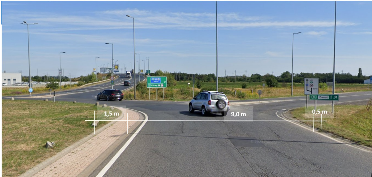
16. ábra: A körpálya keresztmetszeti kialakítása
